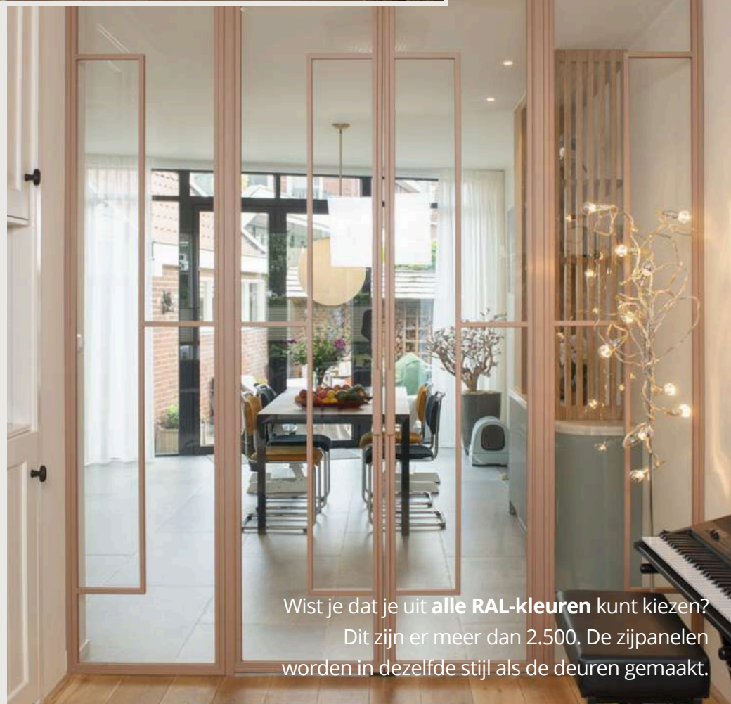
Een eigen ontworpen dubbele stalen deur, met aan de zijkant een glazen wand. Beiden voorzien van helder veiligheidsglas.
